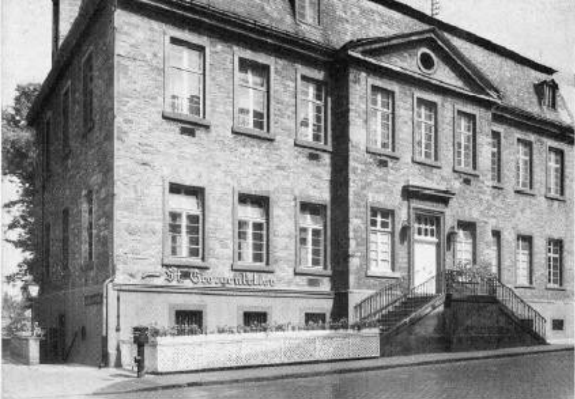
Die Ressource nach dem Wiederaufbau 1948/49 mit dem neuen St. Georgenkeller
